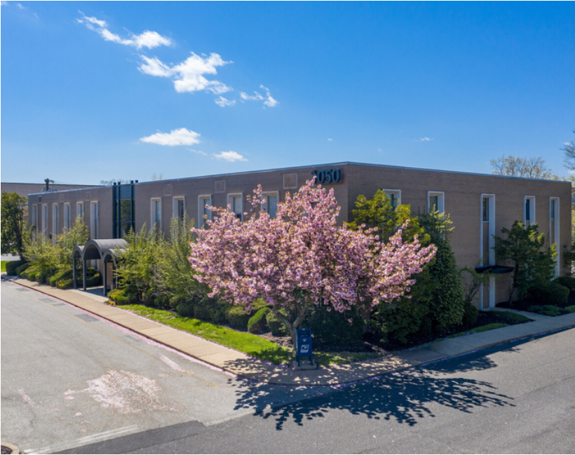
1050 N. KINGS HIGHWAY
