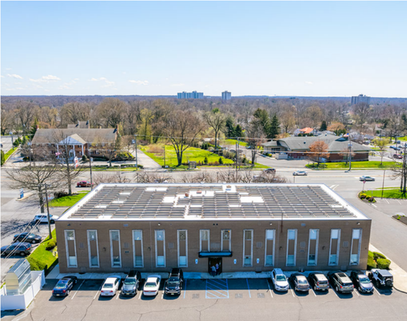
1020 N. KINGS HIGHWAY
