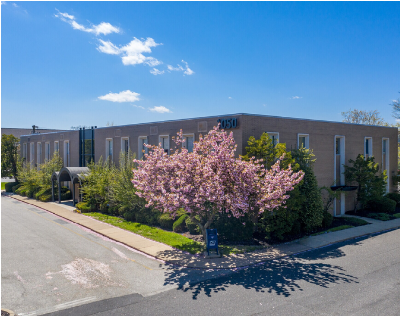
1050 N. KINGS HIGHWAY
