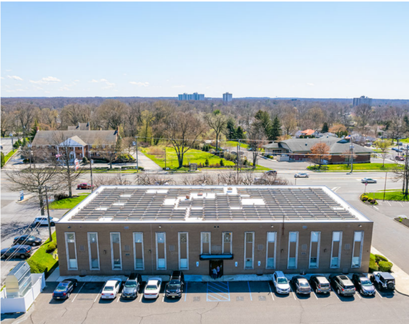
1020 N. KINGS HIGHWAY
